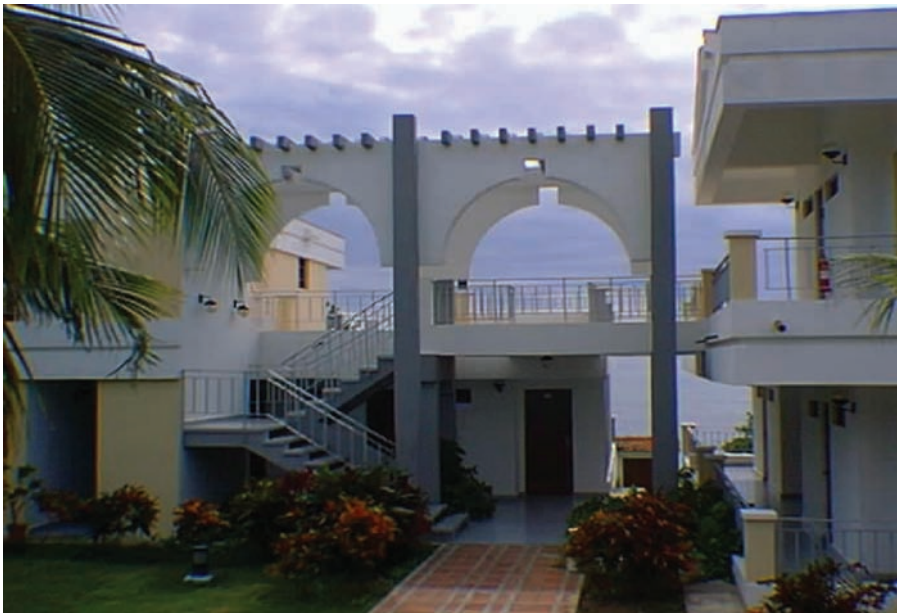
Fig. 27 Detalle del nuevo bloque habitacional B.
