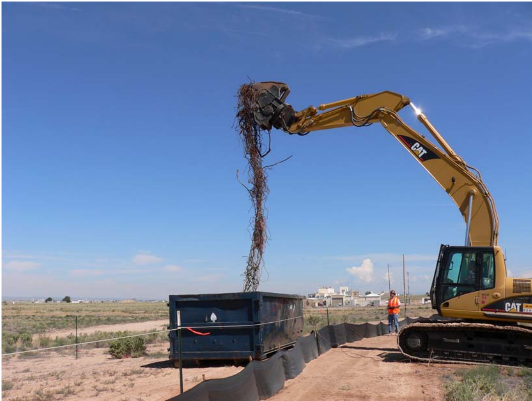
LTES Site 1 Cable Recycling
