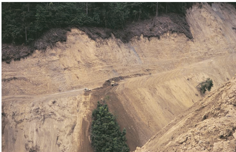
Construcción de la carretera La Bonita-Lumbaquí
